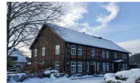
zum Wohnhaus umgebaute Wassermühle heute
